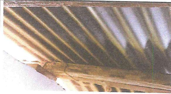
Foto 3: Madera deteriorada por el paso del tiempo
