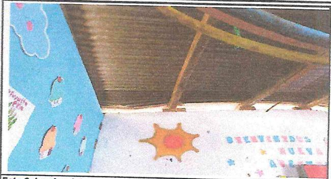
Foto 2: Lamina deteriorada y madera rajada amarada con alambre
