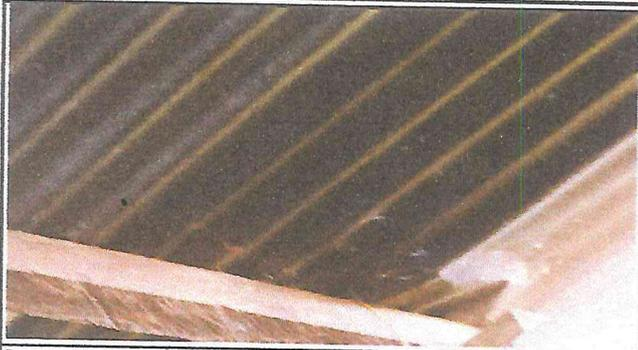
Foto1: Lámina destruida porque hay un cocal que colinda y le caen los cocos encima
